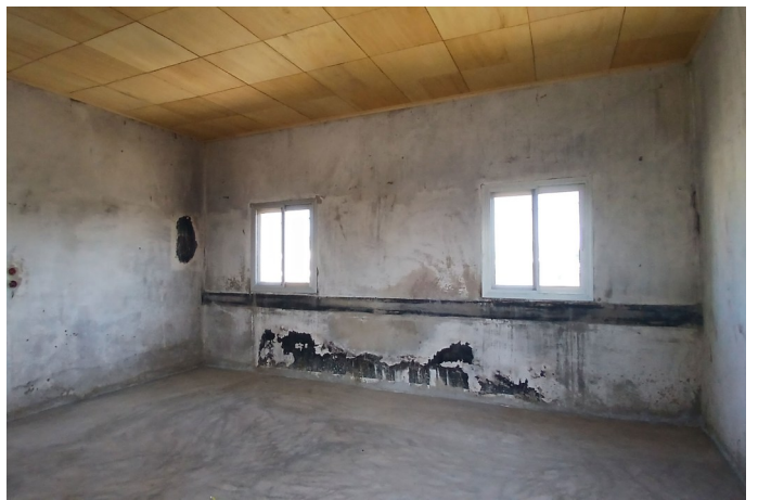
Das Sekretariat: Abel beginnt am Tag nach dem Brand mit den Aufräumarbeiten (links). Der Schutt ist beseitigt, der Fußboden neu gemacht und die Holzdecke eingezogen. Auf die Wände wartet jetzt noch der Anstrich. Wenn die Elektroinstallation fertig ist, kann der Raum wieder benutzt werden.
