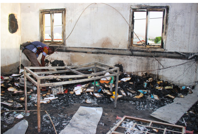
Das Sekretariat: Abel beginnt am Tag nach dem Brand mit den Aufräumarbeiten (links). Der Schutt ist beseitigt, der Fußboden neu gemacht und die Holzdecke eingezogen. Auf die Wände wartet jetzt noch der Anstrich. Wenn die Elektroinstallation fertig ist, kann der Raum wieder benutzt werden.
