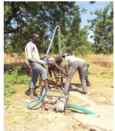
Die Brunnenbohrarbeiten auf „unserem“ Gelände in Bogo
