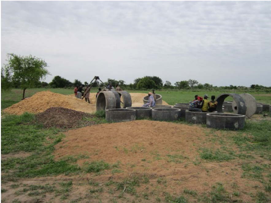
Die Brunnenbaustelle in Patawal
