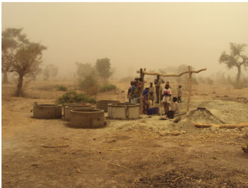
Die Brunnenbaustelle bei unserem letzten Besuch
