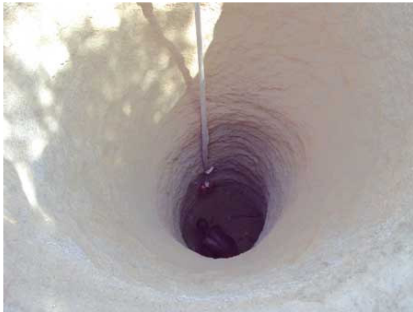
Arbeitsplatz in 7 m Tiefe
